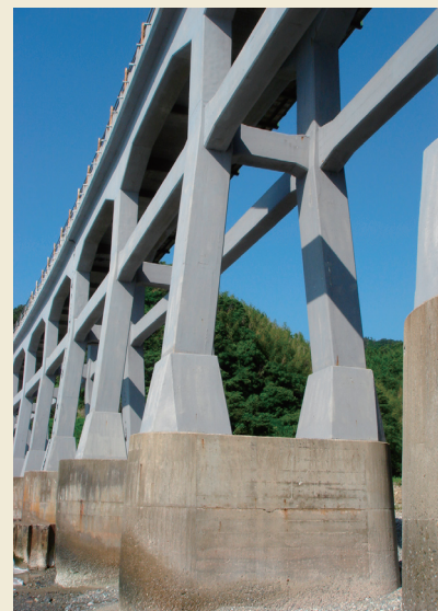
* 惣郷橋梁橋脚部（現状）。強度と耐久性を高めるために橋脚にはラーメン構造（鉄筋コンクリートの柱による格子状の構造）を採用しています。
