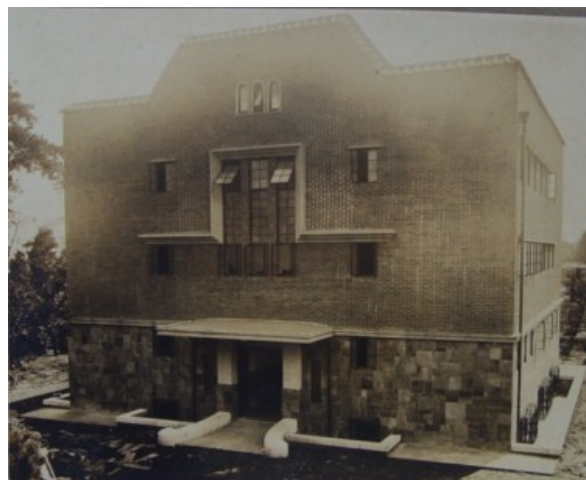
関東大震災後、昭和3年に新築された鉄筋コンクリート造りの毛利家文庫書庫(小山良昌氏「公爵毛利家時代の写真群」『山口県地方史研究』101号より引用)
