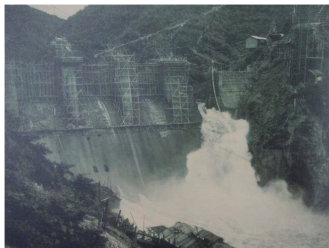
▲向道ダム（堰堤正面図と放水試験写真）
