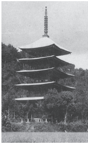
■ 大正修理前の瑠璃光寺五重塔（推定）
