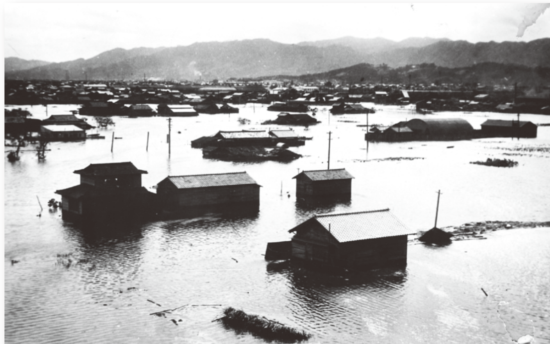
昭和29年 台風12号による被災状況(岩国市)
