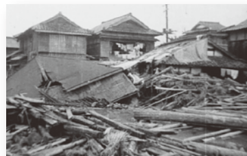
昭和26年 佐波川水害による被災状況(山口市徳地堀)
