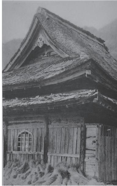
(おそらく台風)被害により、大がかりな修繕を要する状態に陥っていたと思われる。同様のダメージを負っていた瑠璃光寺五重塔は、翌年四月に根本修理が要望されたが、予算と技術者の手配の都合により応急修理での対応となり、波板トタンを用いた屋根葺き替えて急場をしのいでいる。
