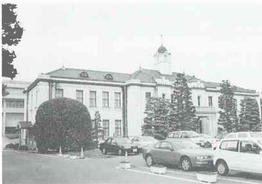
(写真3) 現在の旧県会議事堂
