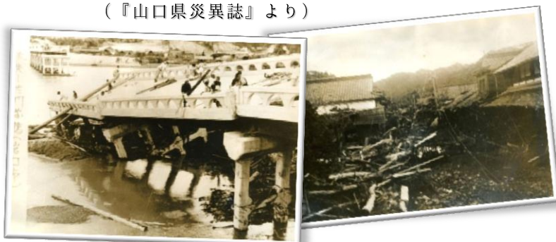
No.25 昭和26年ルース台風被害実況写真
